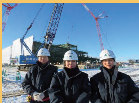
施工管理を担当されている帯広こまちの皆様
