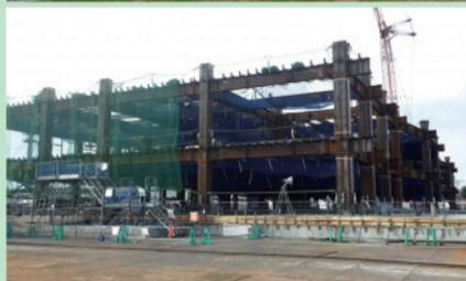
エネルギー棟と病棟部分の3階スラブ(床)までの鉄骨を組み立てていきました。
