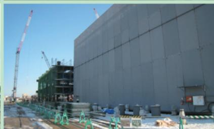
エネルギー棟の鉄骨が完了し、コンクリートを敷きました。病棟部分は引き続き、鉄骨の組み立てを行いました。
