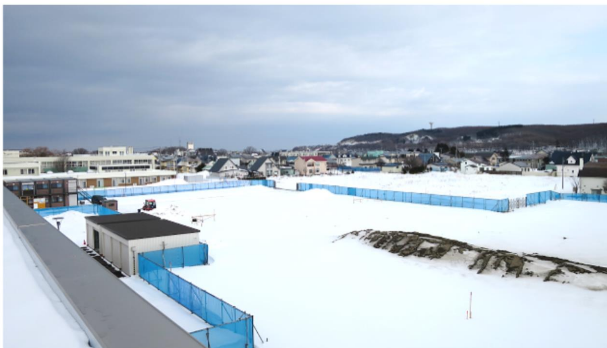
病院屋上からみた特養ところ建設風景 ① 令和3年1月（冬の間は休工中です）
